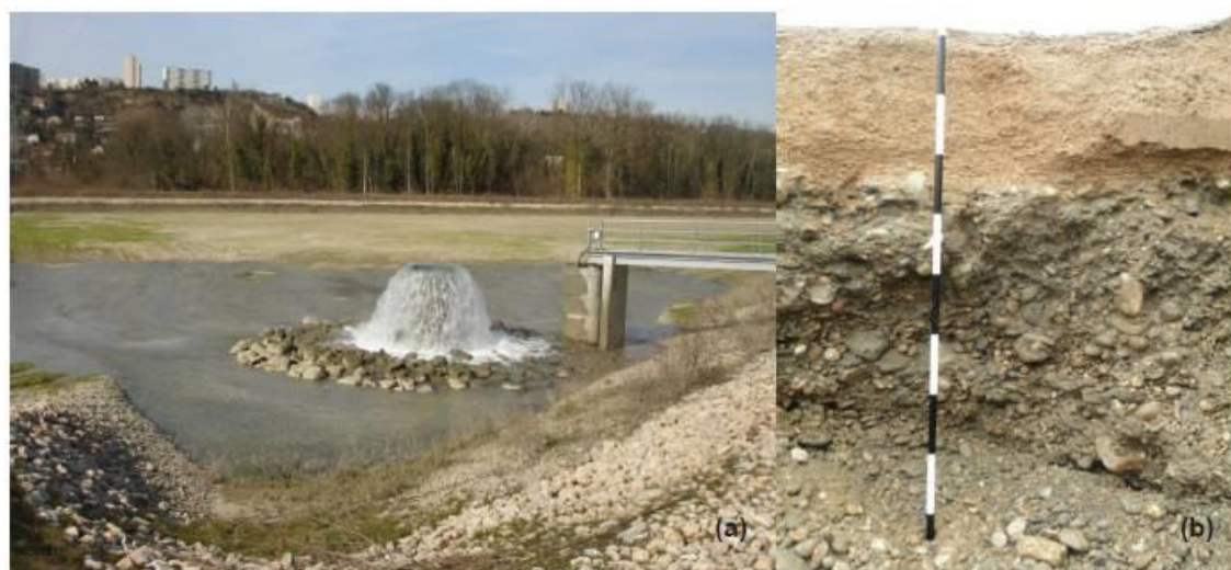
Figure 11 – Vue du remplissage d'un bassin d'infiltration (a) et d'une tranchée dans le fond d'un bassin d'infiltration (b) (Loizeau 2013)
