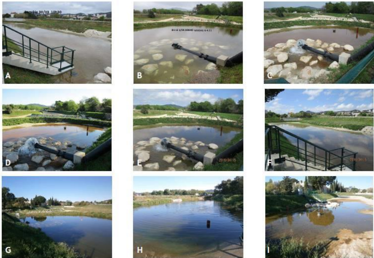
Figure 9 - Planche photo du bassin d'infiltration en fonctionnement lors des essais de qualification en 2015
